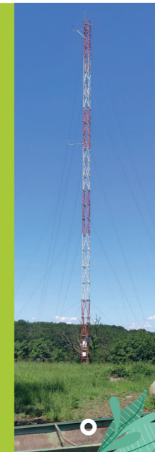
Mât de mesure installé entre La Vie et Lamais
